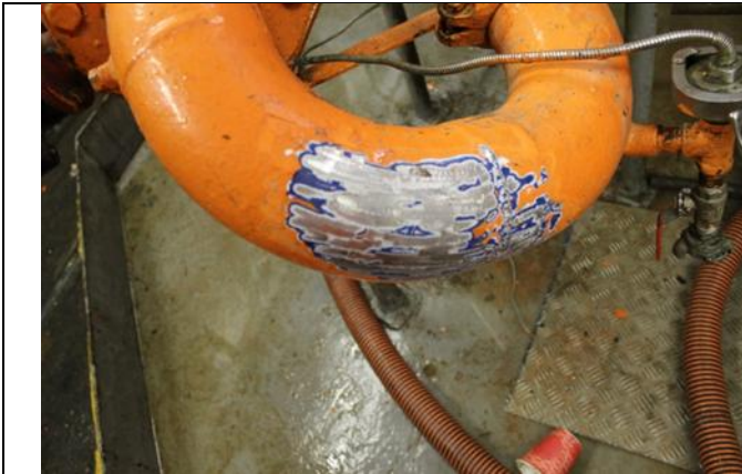
Stålet er rent og fritt for korrosjon
